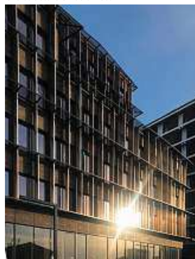
L'Arboretum (à gauche), à Nanterre, prévu pour 2022, et Perspective (à droite), à Bordeaux, livré à l'été 2018, deux immeubles de bureaux à la structure en bois massif.
